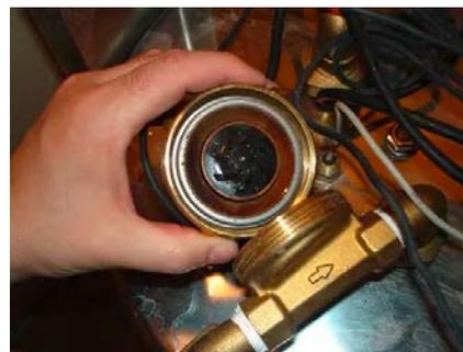
Die Rotorkugel wird zum Säubern aus dem Gehäuse herausgenommen. Etwaige Braureste dürfen die Bohrungen nicht verstopfen und müssen somit vorsichtig entfernt werden.
